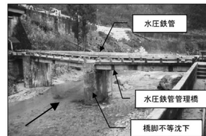
永松発電所水圧鉄管管理橋被災状況
