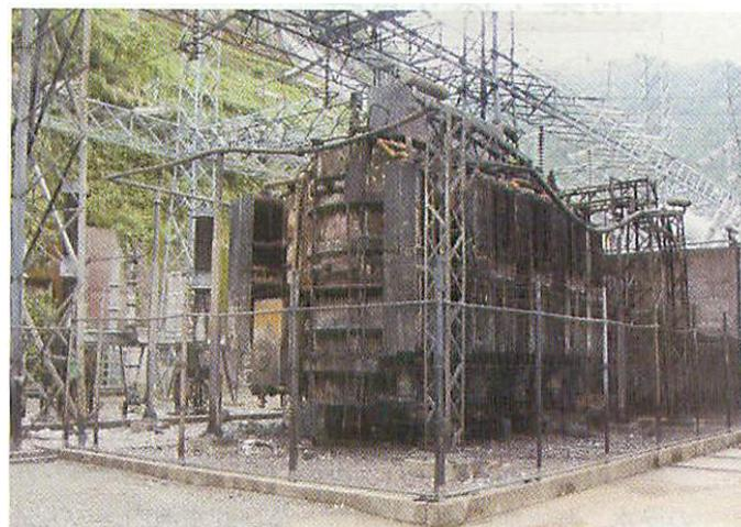
上椎葉発電所 変圧器損傷状況
