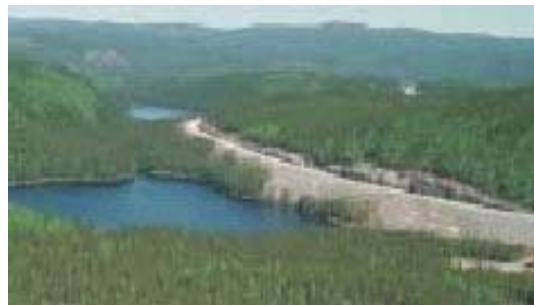
発電所および遠隔地へのアクセスを向上させるために建設された 86 km の道路
