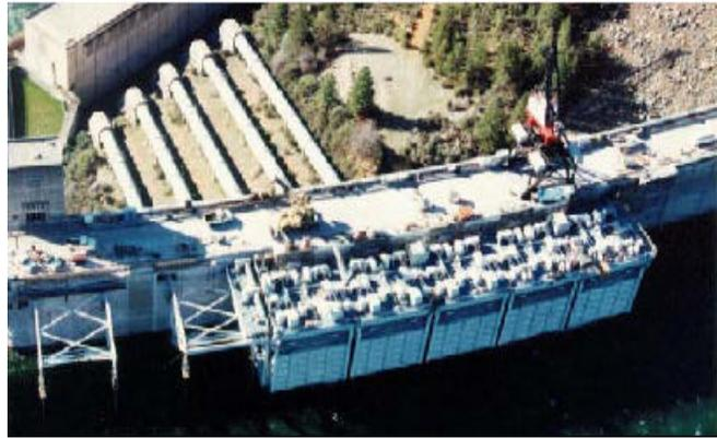
図1 Shasta ダム水温調整装置
