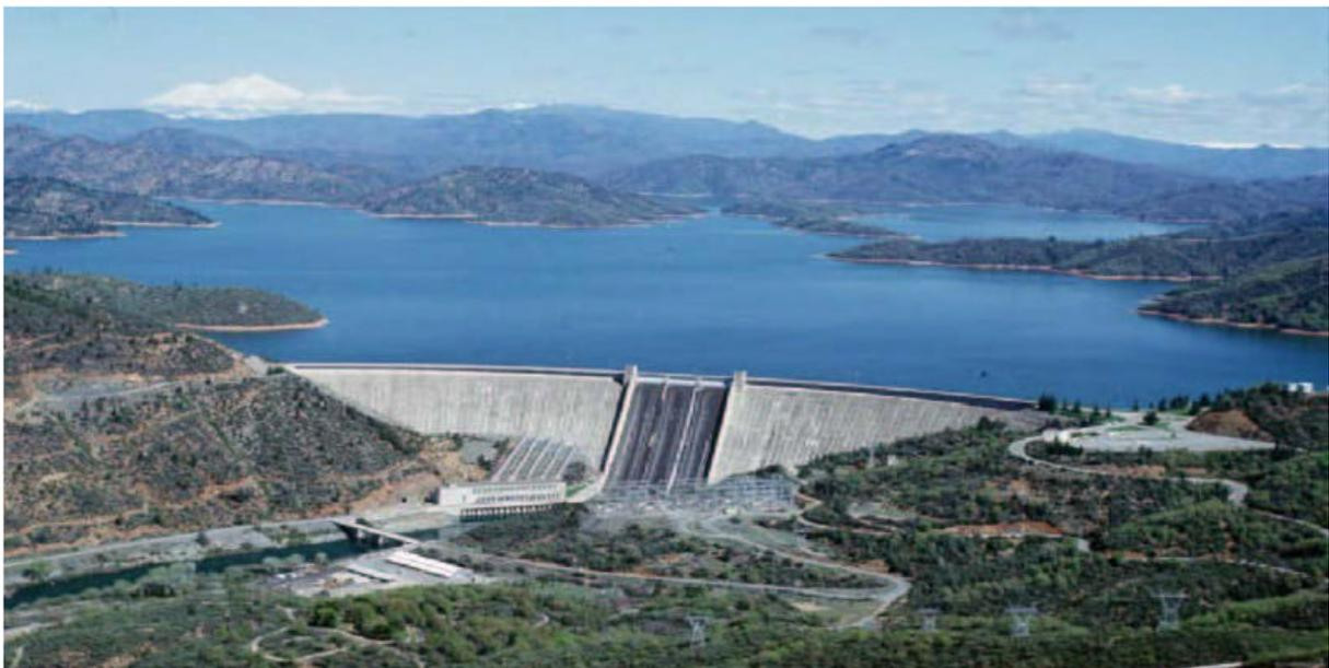
図2 Shastaダム(前方は水圧鉄管、発電所、洪水吐き、後方はShasta湖)
