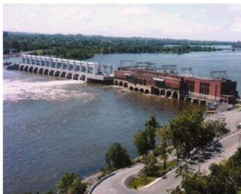
写真-11: 河川と流れ込み式発電 (ケベック州、Rivière-des-Prairies)
