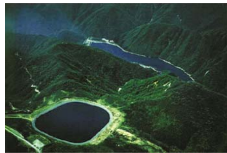
写真-12: 沼原一揚水発電所 (日本)
