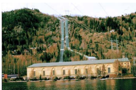
図-10:Nore発電所— 高落差流れ込み式発電所(ノルウェー) 撮影 A.M. Tvede
