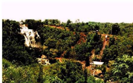
写真-8:ミニ水力プロジェクト (インドネシア, Kotaway)
