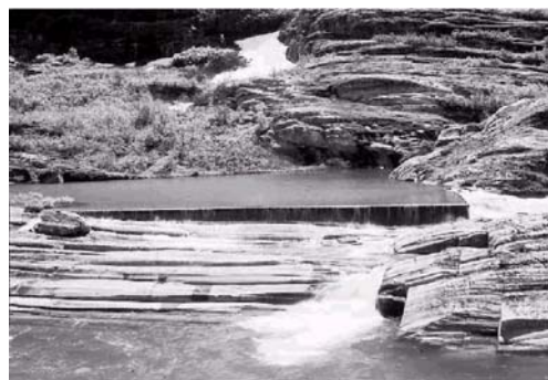
写真-13: 減水区間における小さな堰 (ノルウェー)
