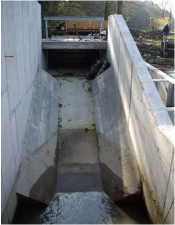
図3 水車ケーシング架台
