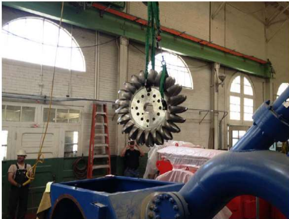
図 - 2 新しいタービンの設置
