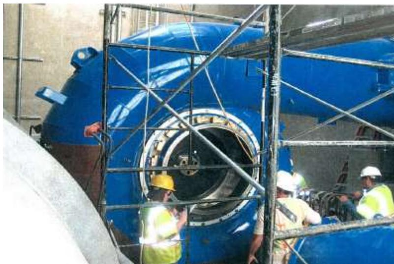
図 - 2 新小水車（据え付けレベリング中）
