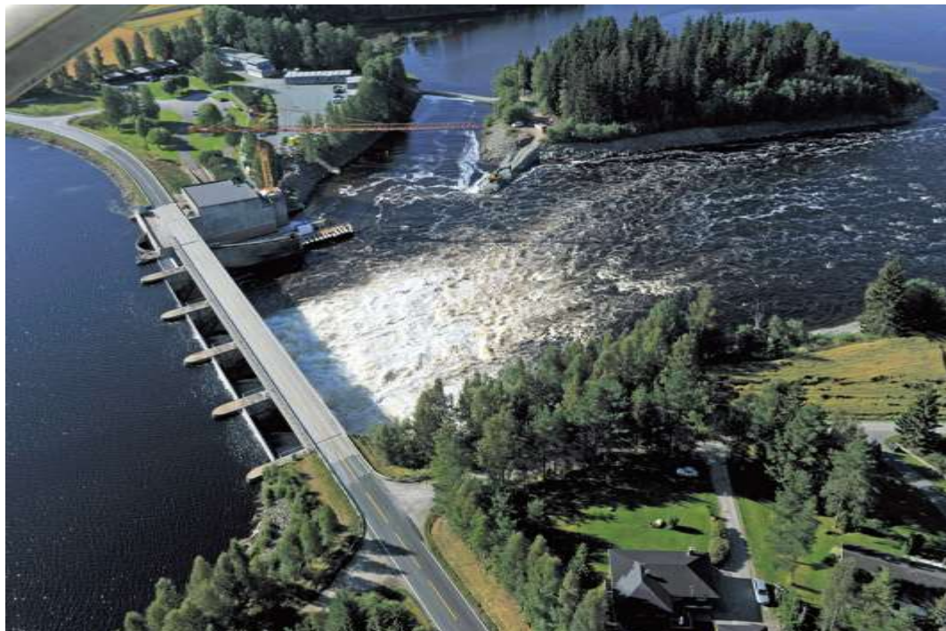
Kongsvinger 水力発電所
