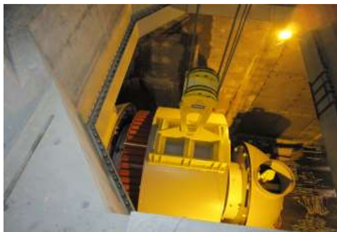
上左：ドラフトチューブ建設 上右：水車ランナの組み立て 下：発電機固定子組み立て
