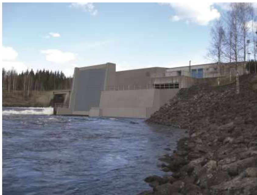
Glomma 川流域の Kongsvinger 発電所
